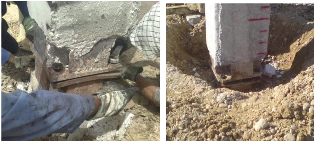
شكل الف-۸- تطويل شمع با اتصال پیچی. همانطور که در تصاویر فوق مشاهده می‌گردد، تراز نبودن صفحات اتصال باعث شده تا برای حفظ زاویه قائم محور شمع بیچ‌ها بطور کامل بسته نشود و اتصال بخوبی برقرار نگردد.
