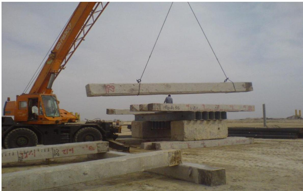
شکل الف-۶- جابجایی شمع از محل قلاب‌های تعییه شده که کمترین لنگر ماکزیمم را ایجاد می‌نماید.
