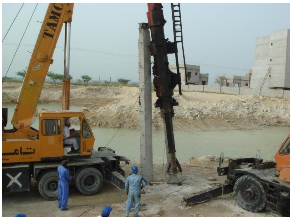
شکل الف-۲۵- شکستگی شمع در اثر عدم اینمنی سیستم کوبش و واژگونی چکش
