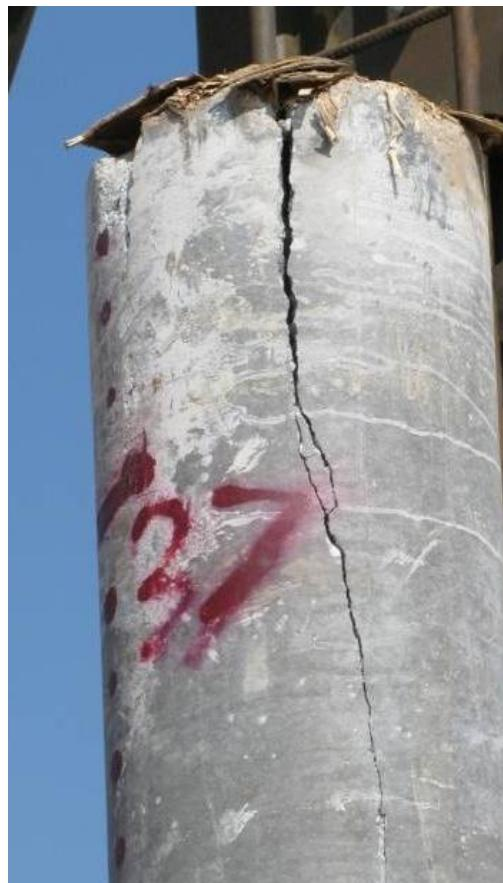
شکل الف-۲- همانطور که در تصویر سمت راست ملاحظه می‌گردد، افزایش بیش از حد قطر کلاهک نسبت به قطر شمع باعث شده تا کلاهک بطور مناسب بر روی شمع مستقر نگردد. این عدم تطابق منجر به ایجاد تمکز تنش و در نتیجه شکستگی راس شمع شده است.
