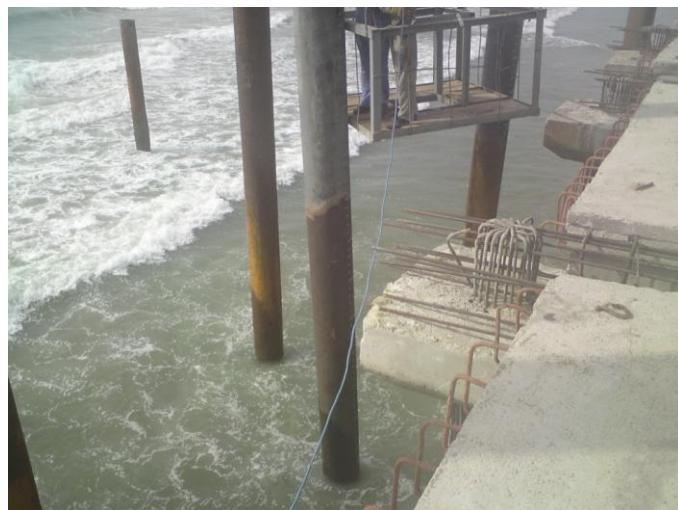
شكل الف-۱۴- بالا ماندن قسمت محافظت شده به علت عدم تعیین صحیح طول قبل کوشش شمع ها
