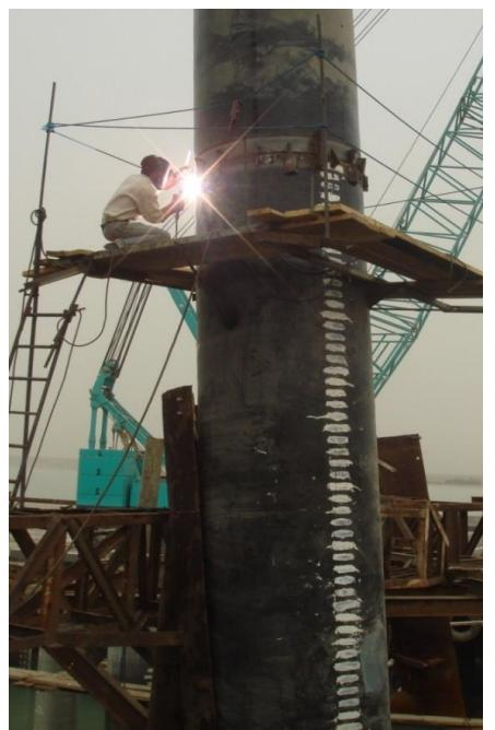
شکل الف-۷- تطویل شمع با اتصال جوشی
